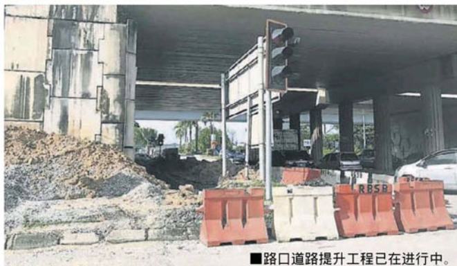
■路口道路提升工程已在进行中。
